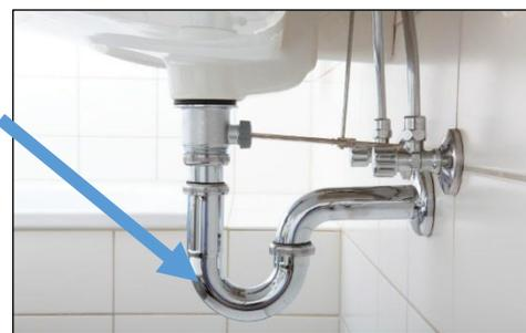
Plusieurs causes de mal fonctionnement du siphon peuvent être pointées du doigt. Par exemple, ce peut être dû à la formation d'un bouchon dans le siphon. En effet, si des cheveux, des poils, des résidus de savon, de la graisse ou des aliments bouchent le siphon, cela forme le foyer parfait pour les microbes et donc les mauvaises odeurs.
