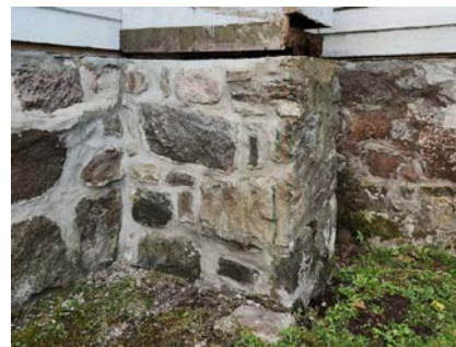
Le même contrefort après l'application du nouveau mortier.
